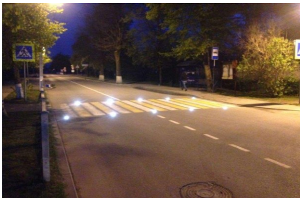
Рисунок 2. Приклади автономного освітлення на пішохідних переходах з датчиками руху
