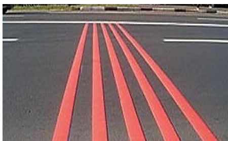
Рис. 1.34. Зовнішній вигляд деяких видів дорожнього обладнання: а – протизасліплювальні екрани; б – смуги шумові.
