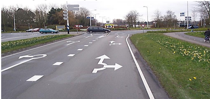
Рис. 1.38. Перекривання перехрестя згідно з ДСТУ 4092-2002 [4].
