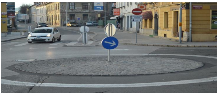
Рис. 1.40. Застосування мінікільця згідно з ДСТУ 4092-2002 [4].
