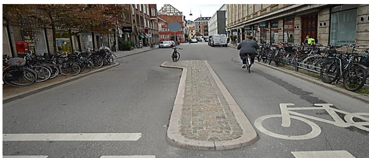
Рис. 1.36. Вставки по осі дороги згідно з ДСТУ 4092-2002 [4].
