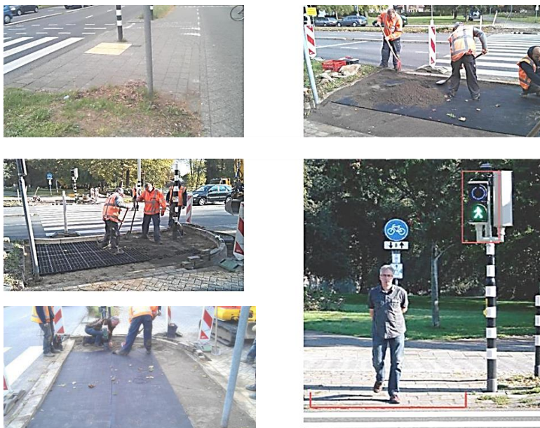
Рис.1 .27. Прилад монтажу детектора пішоходів на підході до пішохідного переходу.
