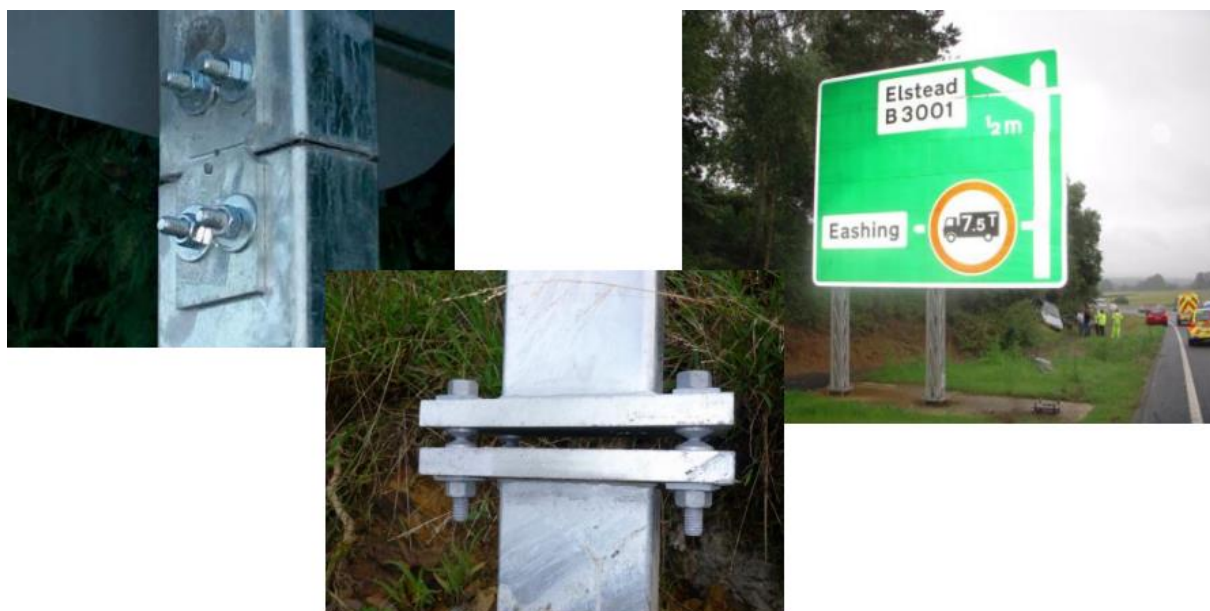
Рисунок 4 – Загальний вигляд зчленування по висоті пасивно безпечних опорних елементів під дорожні знаки
