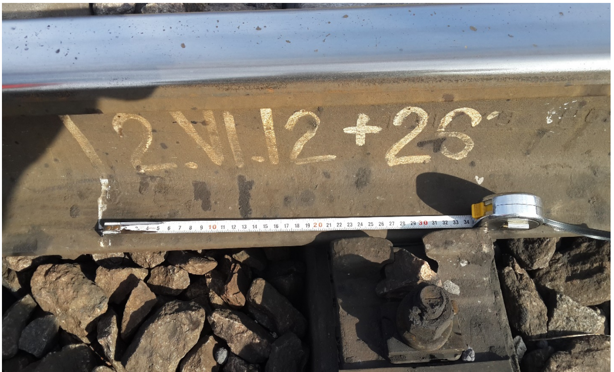
Рис. 23 Угон рейкових плітей безстикової колії на перегоні Червоне Озеро-Седнівка Регіональної філії «Одеська залізниця» АТ «Укрзалізниця»
