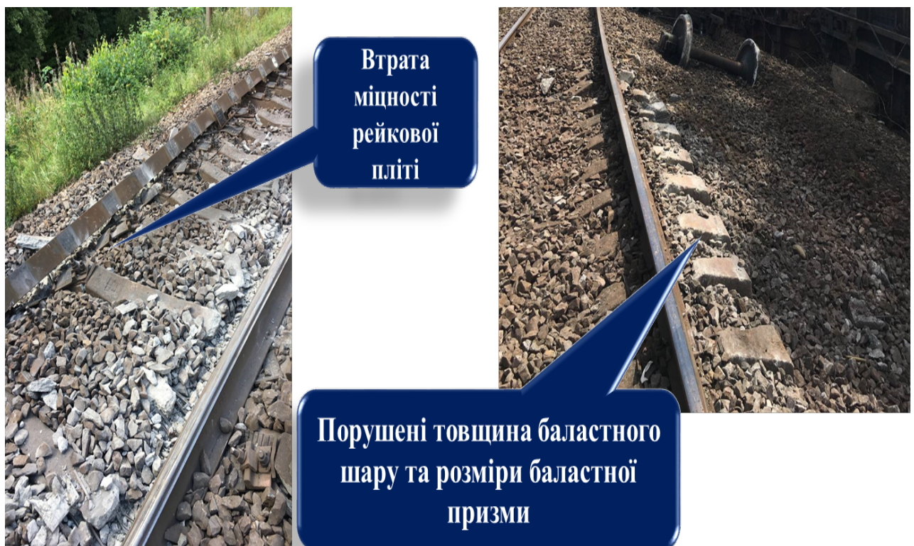
Рис. 21 Стан безстикової колії на перегоні Регіональної філії «Львівська залізниця» АТ «Укрзалізниця»
