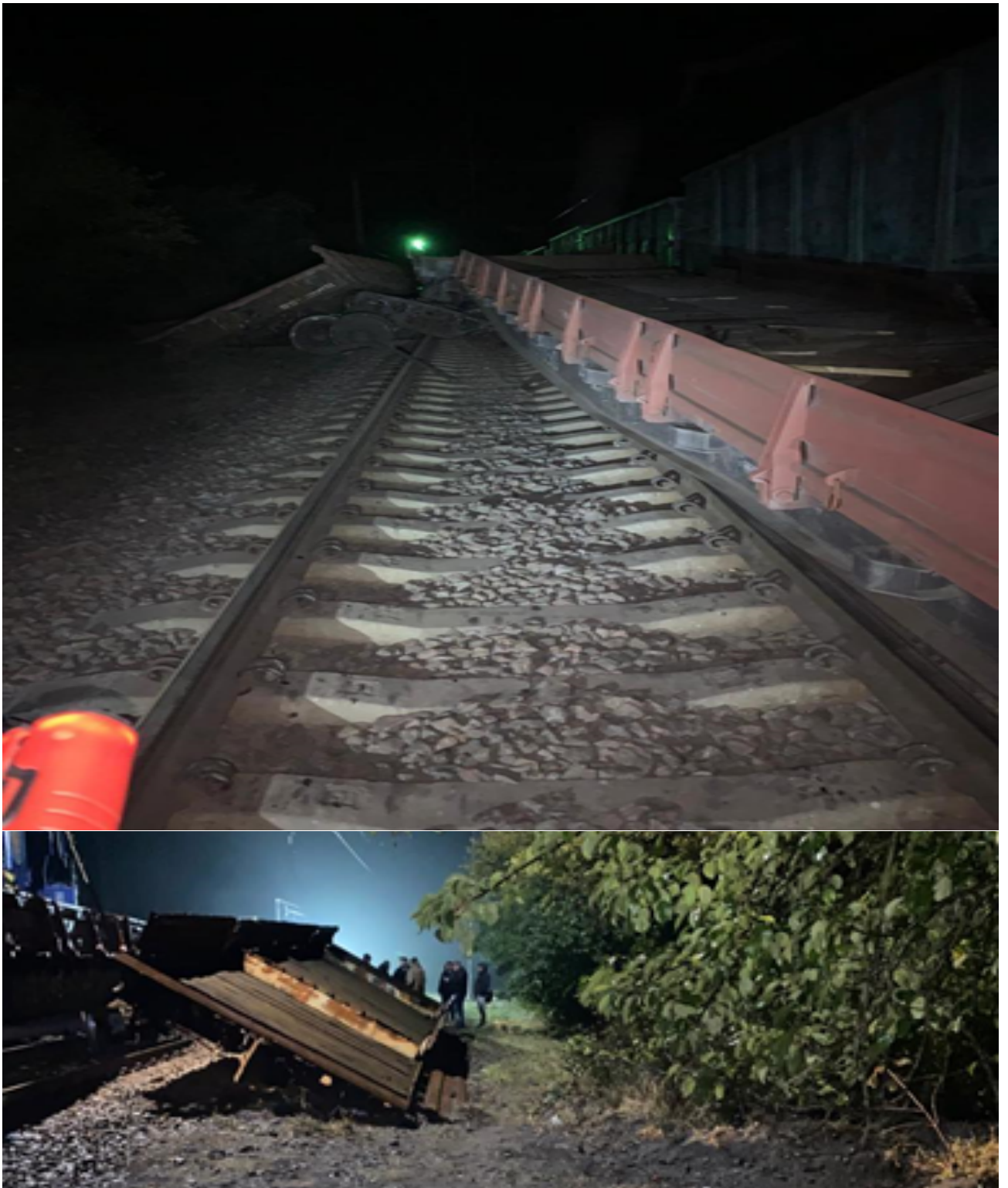
Рис. 2.1. Загальний вид сходження з рейок вагонів №№ 19825959, 19690510 та 19827245 вантажного поїзда № 8402
