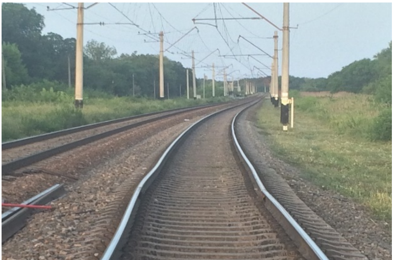
Рис. 25 Початок втрати стійкості безстикової колії на перегоні Гусарівка – Бантишеве Регіональної філії «Донецька залізниця» АТ «Укрзалізниця»
