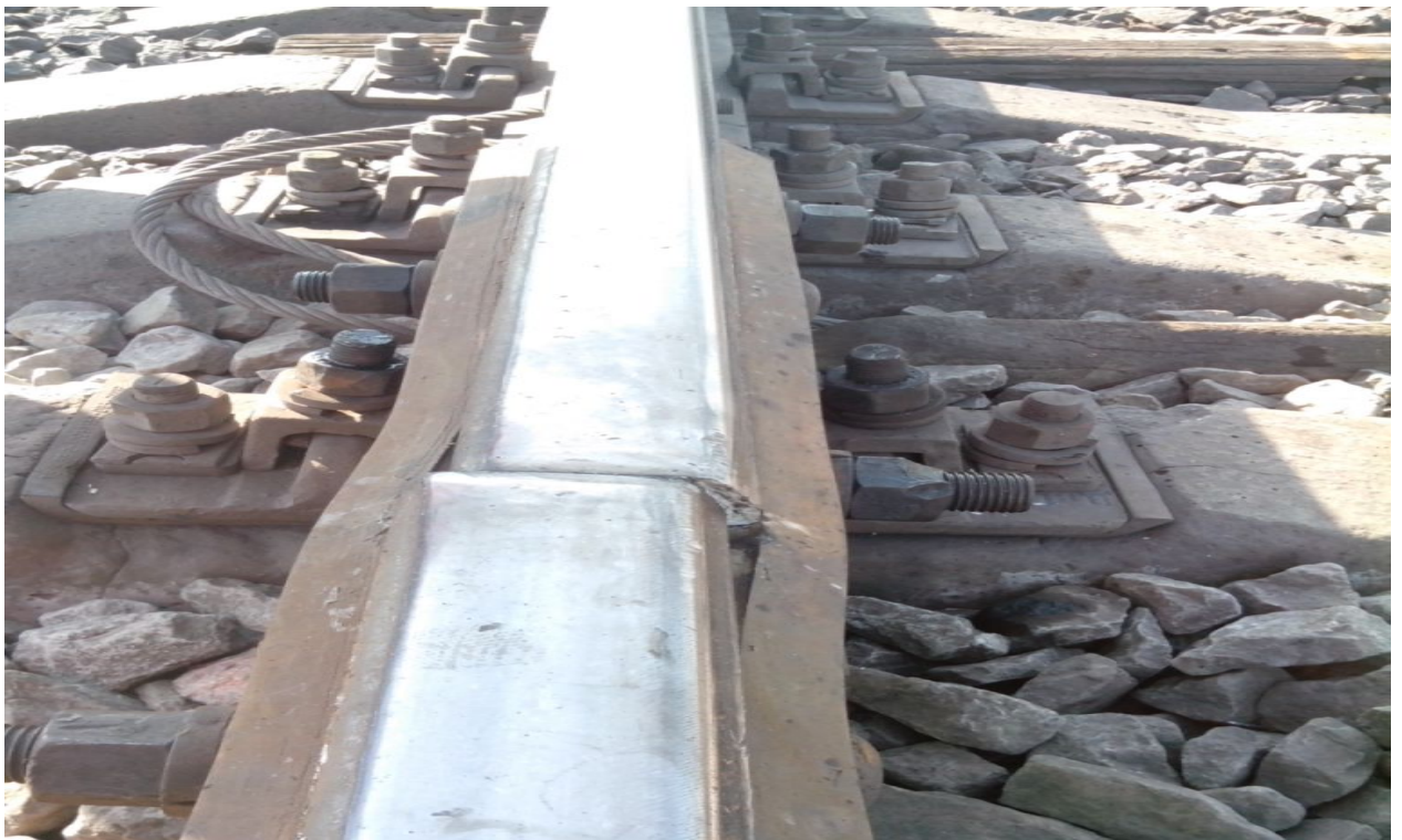
Рис 24 Понаднормативні поздовжні напруження в ізолюючому стику на напрямку Миронівка-П'ятихатки Регіональної філії «Одеська залізниця» АТ «Укрзалізниця»
