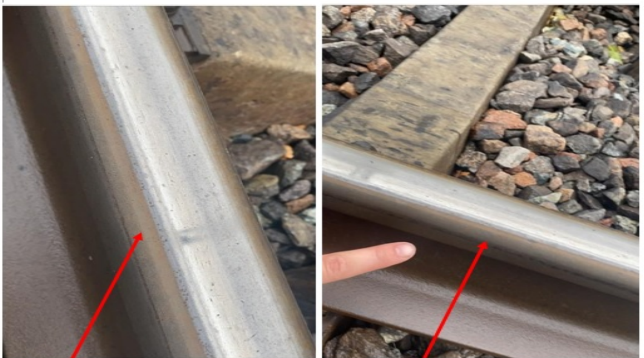
Рис. 3.13. Сліди від тертя гребня на правій та лівій рейці
