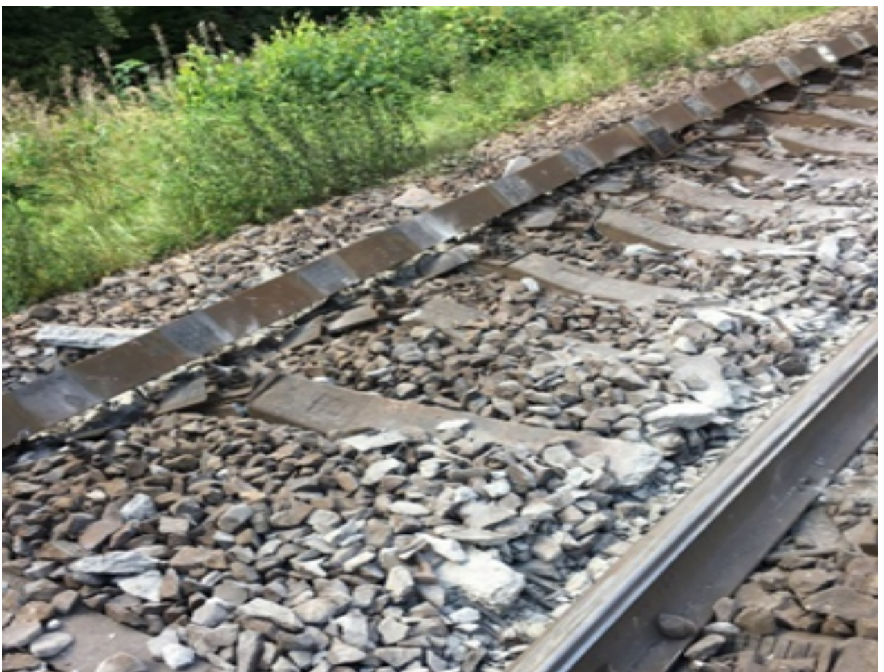
Рис. 59 Втрата міцності залізничної колії та порушення баластної призми
