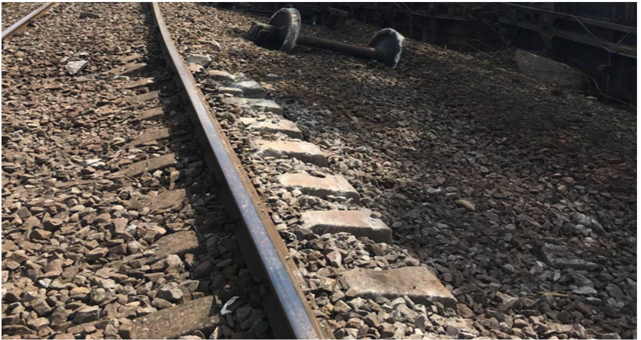
Рис. 58 Втрата міцності залізничної колії та порушення баластної призми
