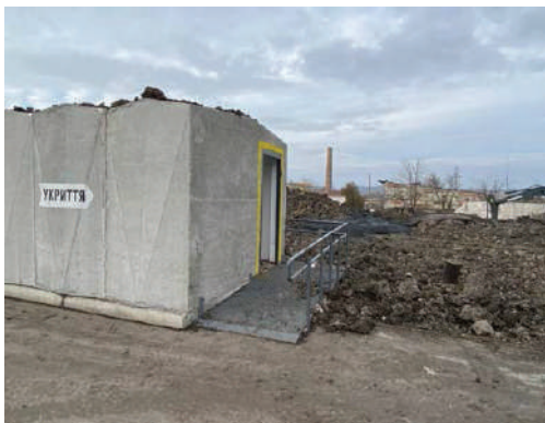
Рис. 4. Зовнішній і внутрішній вигляд первинного (мобільного) укриття блочного типу після влучання поблизу (до 300 м поруч) балістичної ракети
